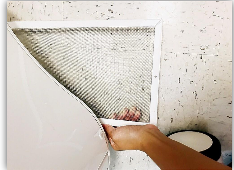
Imagen arriba: pantalla del ventilador situada bajo la consola (acoplado magnéticamente)
